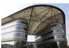
Università di Torino Campus Einaudi: Facoltà di Giurisprudenza, Scienze Politiche e Biblioteca Interdipartimentale (Arch. Foster) Importo lavori: € 70.085.000,00
