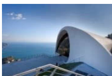
Comune di Ravello Nuovo Auditorium "Oscar Niemeyer" (Arch. Niemeyer) Importo lavori: € 13.186.578,12
