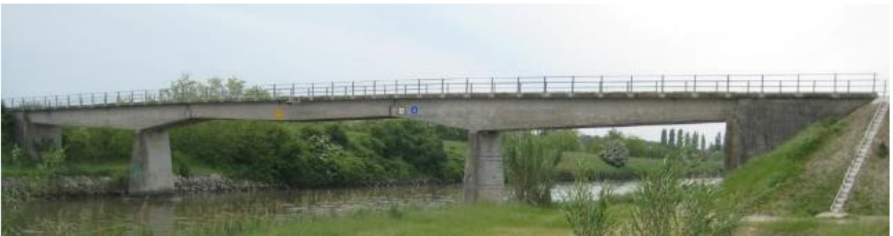
Bridge n.1: an r.c. cantilevered bridge.
