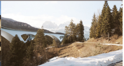
Viadotto Saccomedan, Belluno
