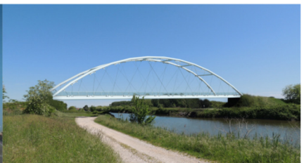
Ponte Rantin sul fiume Po, Rovigo
