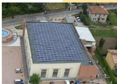
Il progetto consiste nei lavori di riqualificazione energetica della palestra comunale e prevede l'installazione di impianto fotovoltaico al di sopra della copertura di potenza pari a 72,45 kWp.
