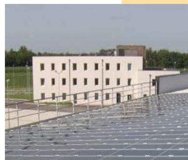
Realizzazione di impianto fotovoltaico integrato sulla copertura dell'edificio officina con le seguenti caratteristiche: potenza elettrica 114,861kW<sub>p</sub> producibilità attesa 125.300 kW h/a
