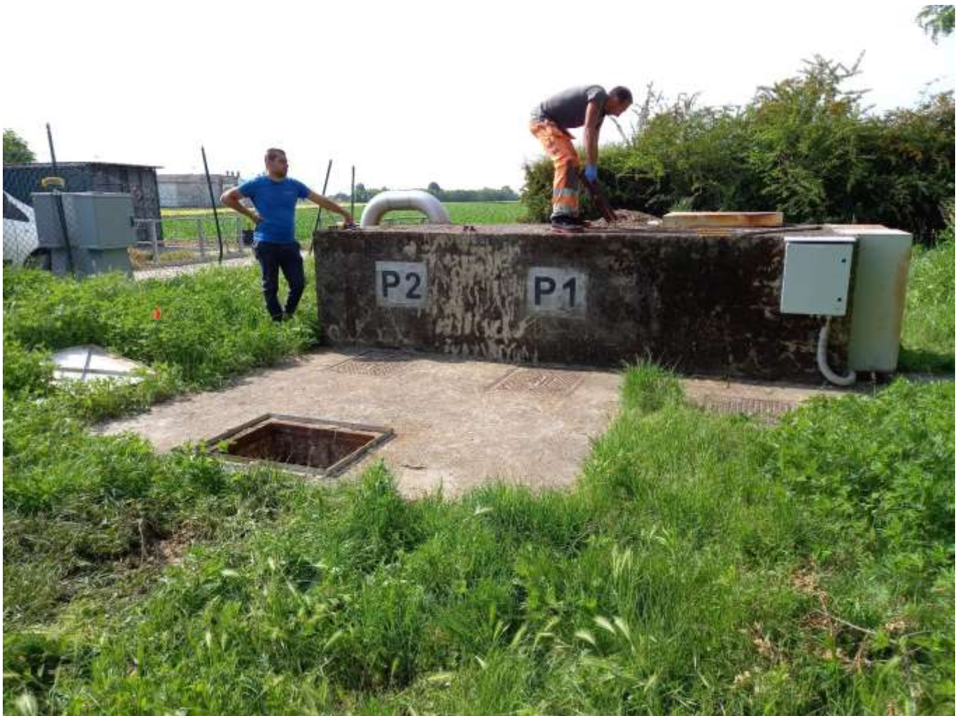
Figura 6 -manufatto esistente (vista da nord verso roggia Motta)
