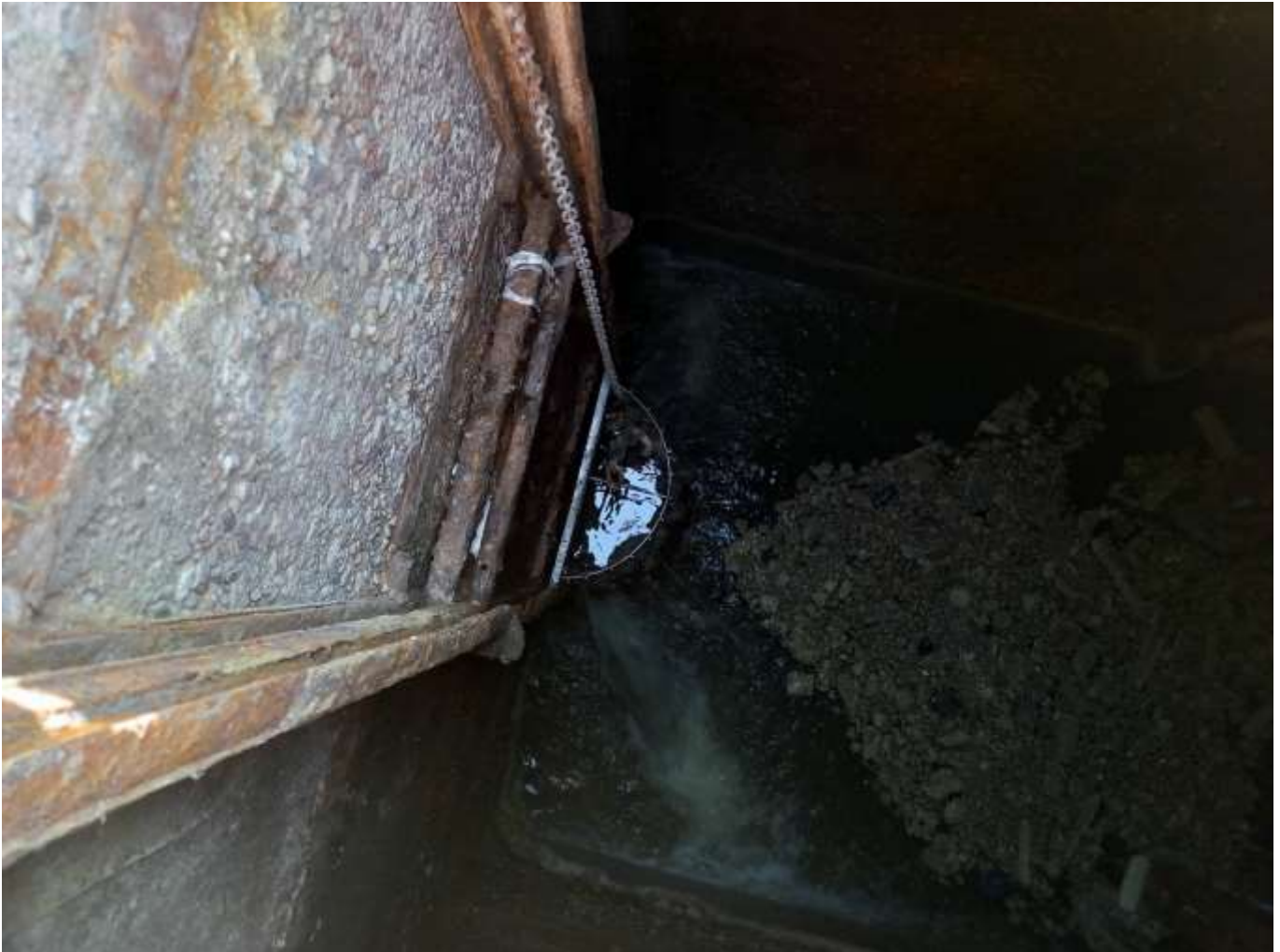
Figura 8 - manufatto esistente (interno stazione di sollevamento - griglia)
