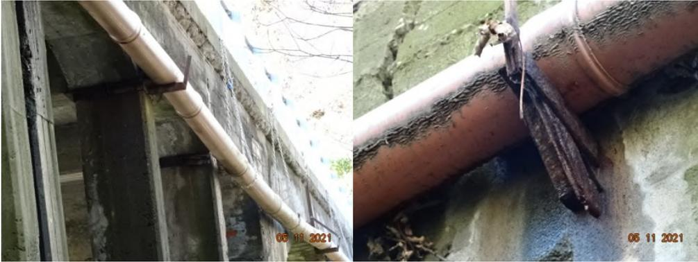
Le mensole di sostegno della condotta sul bordo della struttura in cemento armato del ponte sul torrente Pellino. E' stata la rottura di alcune di queste mensole a provocare, con effetto domino, una grave instabilità della condotta esistente con rischio di crollò e di interruzione del servizio di rifornimento dell'acqua potabile agli utenti del Comune di Arola.
