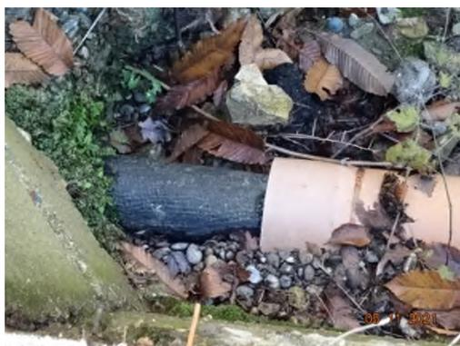
La condotta In acciaio esistente alla fine del ponte sul torrente Pellino, sul fianco della struttura in cemento armato del ponte. In questa posizione è previsto l'allaccio, prima della condotta provvisoria in PEAD 90mm in progetto e, in seguito, della condotta definitiva preisolata in PEAD 110/200mm in progetto.
