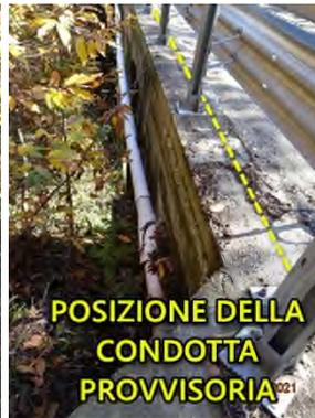
Il ponte sul torrente Pellino, con indicata la posizione dove viene prevista la posa della condotta provvisoria in PEAD 90mm in progetto, necessaria per assicurare il rifornimento idrico agli utenti del Comune di Arola durante la realizzazione dei lavori previsti in progetto. La condotta provvisoria non interferirà con la carreggiata della strada provinciale SP78 e sarà installata presso il guard rail della strada provinciale SP78.
