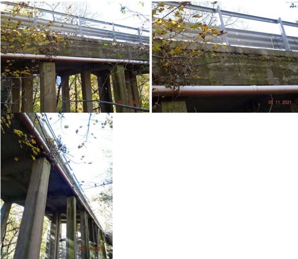
Le immagini sono relative alla posizione della condotta esistente in acciaio e della sua protezione in PVC presso il bordo dell'impalcato della struttura in cemento armato del ponte sul torrente Pellino.
