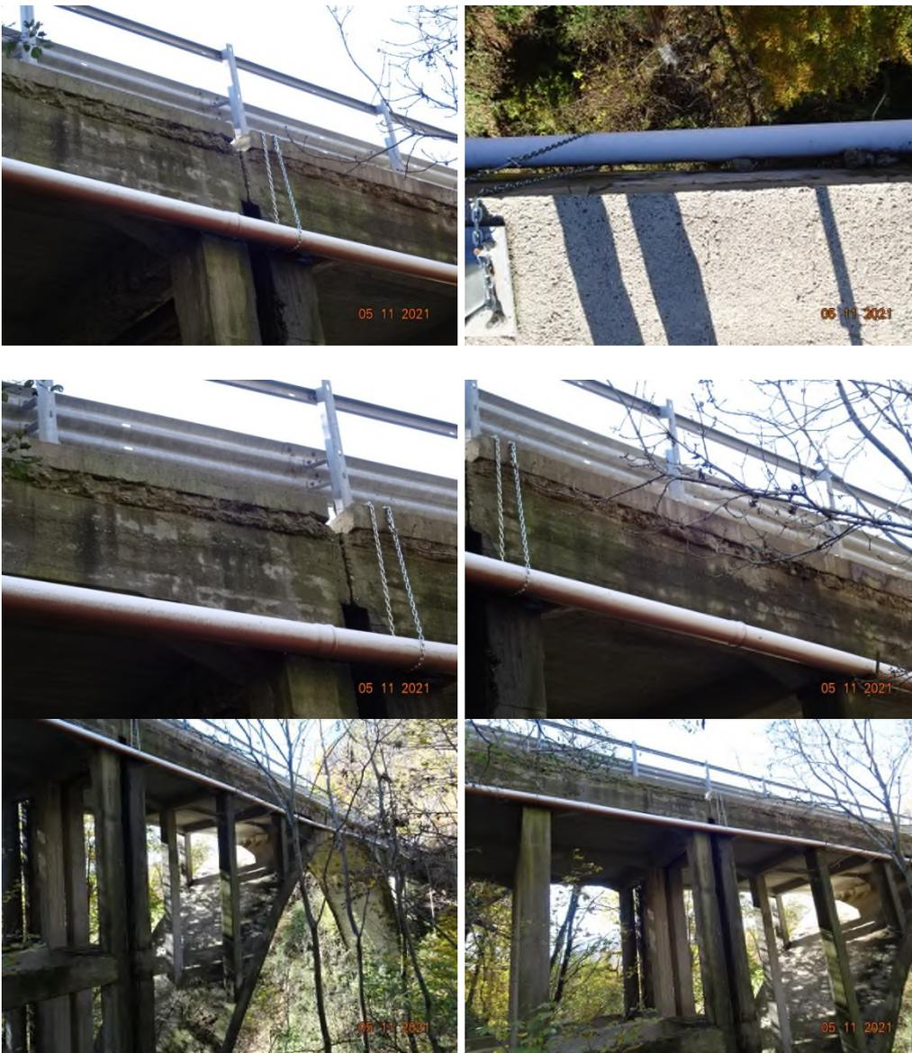
Per evitare il pericolo di crollo della condotta e la conseguenza mancanza di rifornimento idrico al Comune di Arola, Acqua Novara Vco S.P.A. si è ritrovata costretta ad installare delle catene provvisorie per il sostegno della condotta esistente al soprastante guard rail della strada provinciale SP 78.
