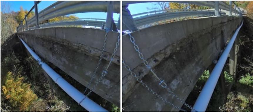
La condotta esistente in acciaio, con la sua protezione esterna in PVC, installate presso il bordo della struttura in cemento armato del ponte sul torrente Pollino, in Comune di Arola, in Provincia di Verbania.
