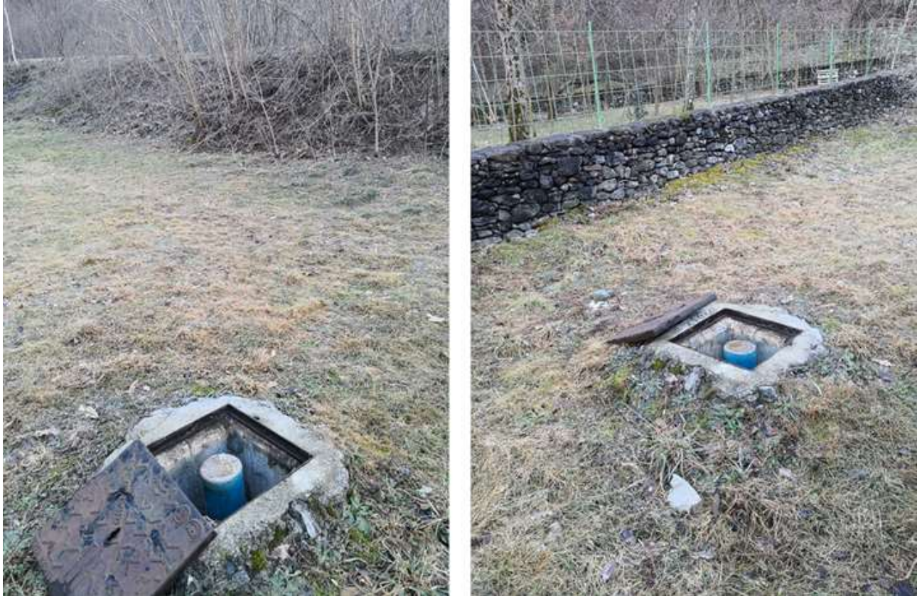
Figura 3 - testa pozzo esistente. A sinistra, vista verso rio Blet, a destra vista verso proprietà privata
