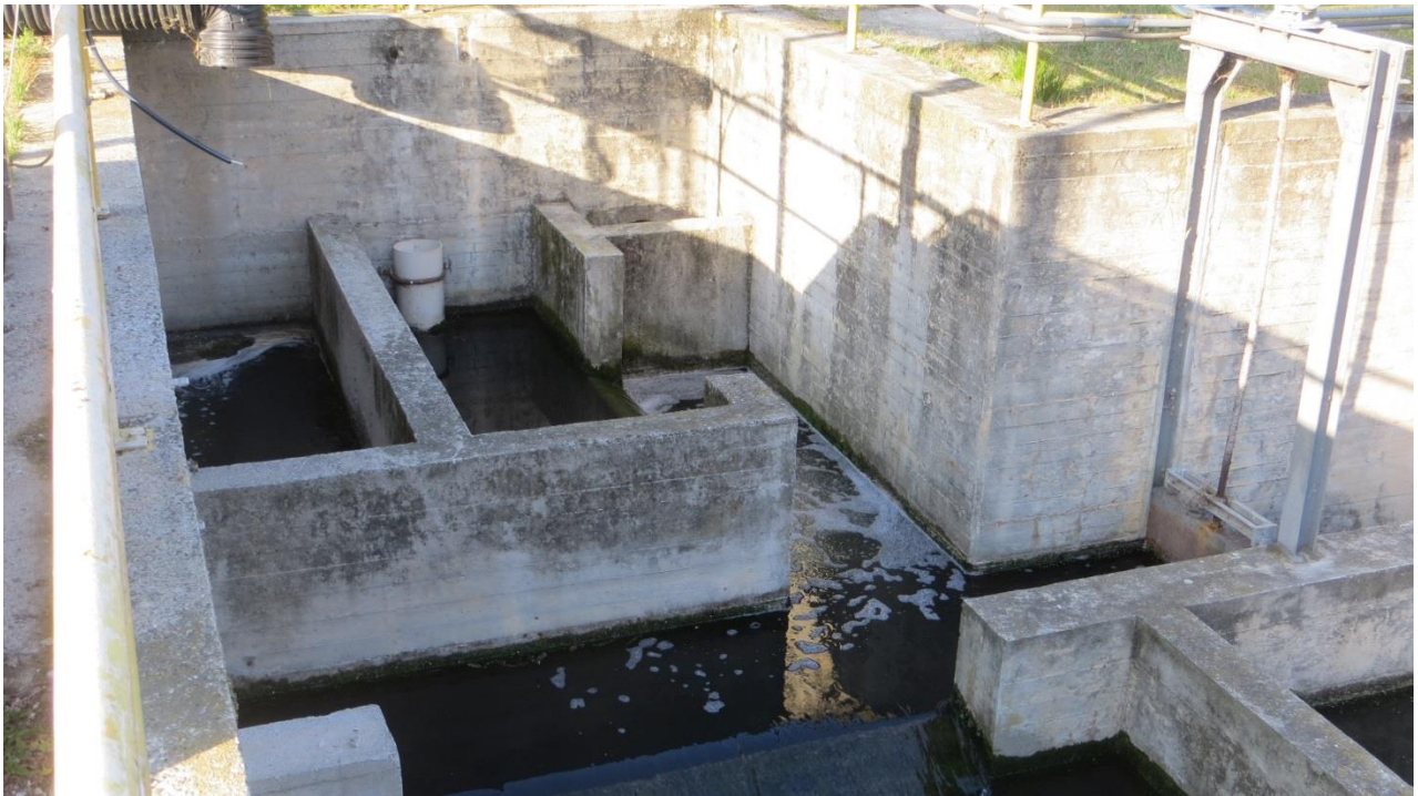
Impianto esistente: circuito iniziale clorazione
