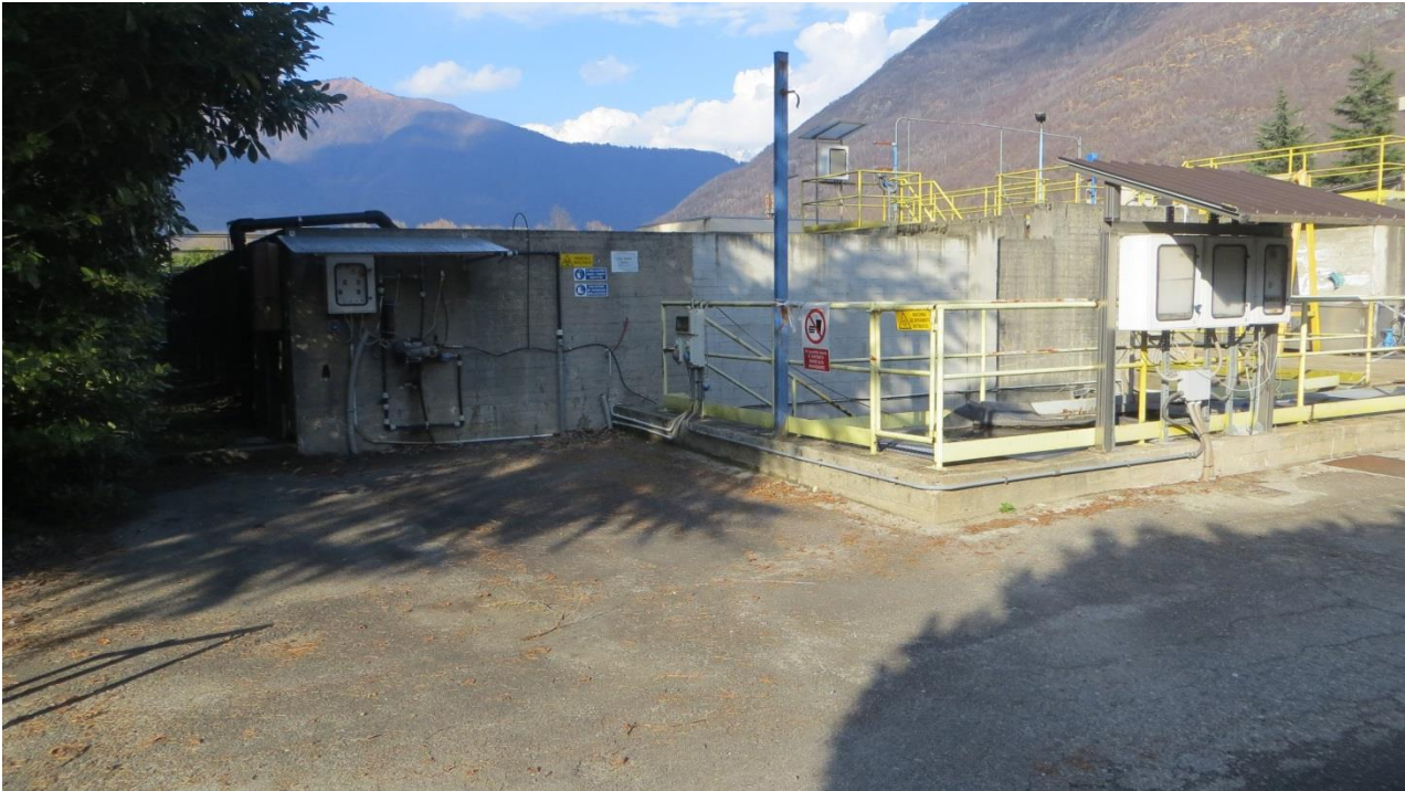
Impianto esistente: zona pretrattamenti e vasca equalizzazione esistente
