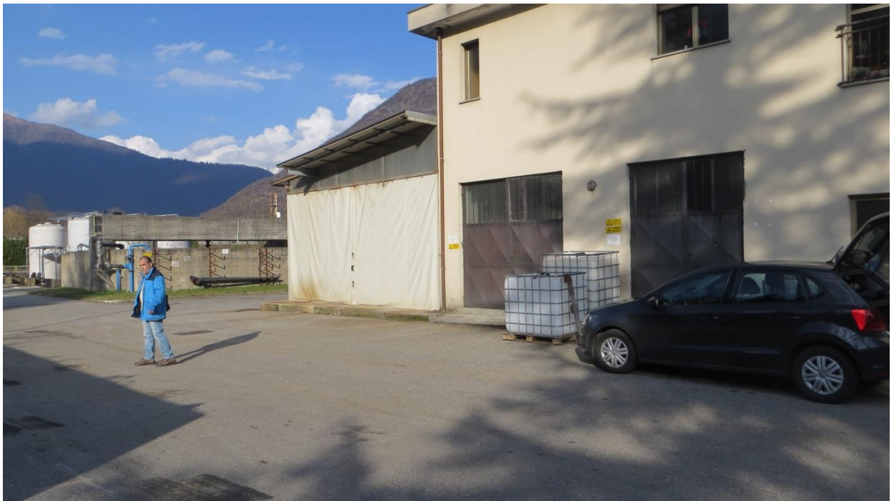
Impianto esistente: edificio tecnico e locale disidratazione annesso
