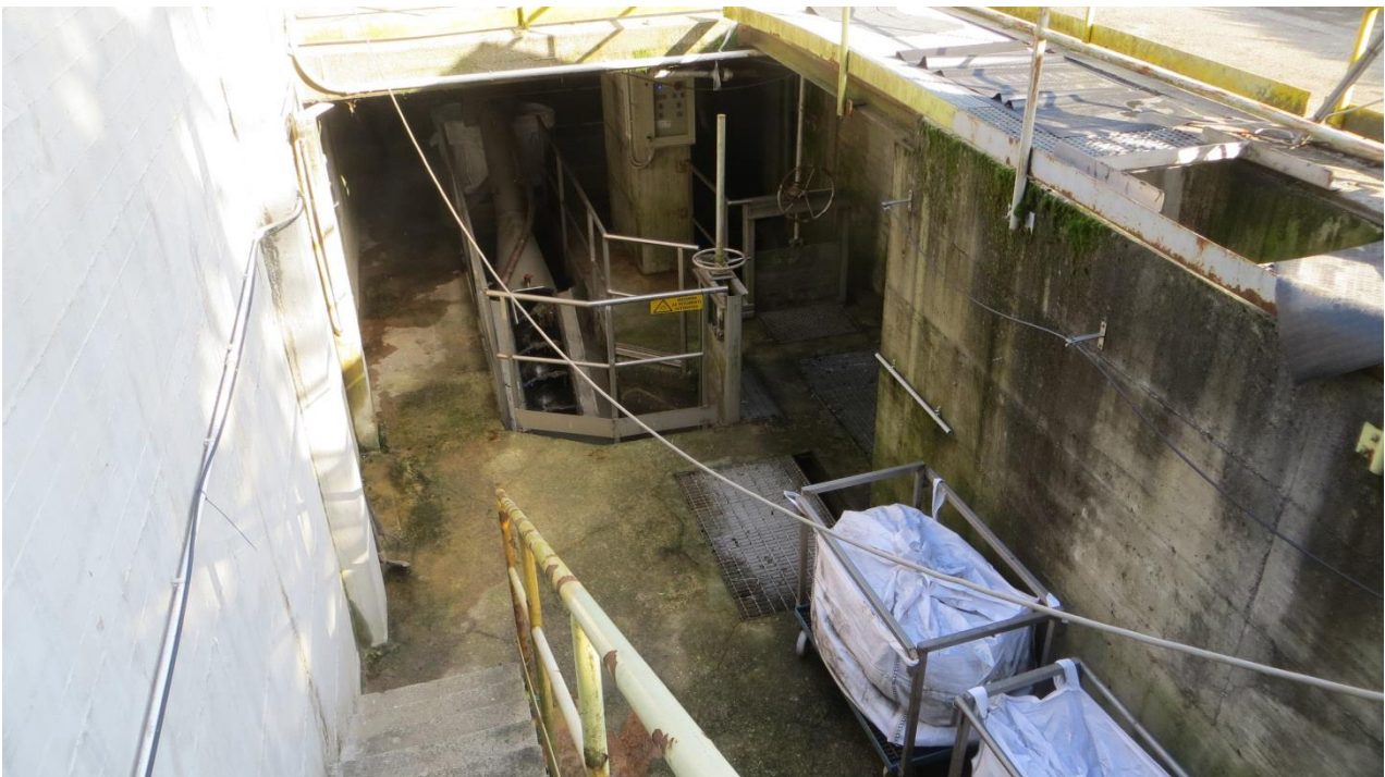
Impianto esistente: zona pretrattamenti attuali (da dismettere)
