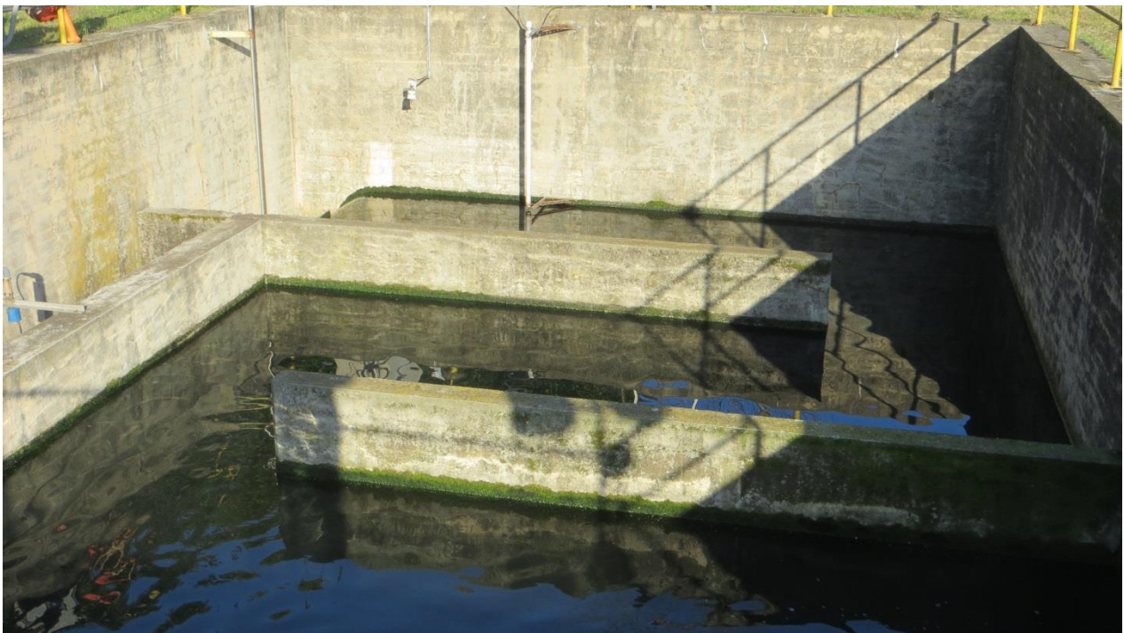
Impianto esistente: setti interni alla clorazione
