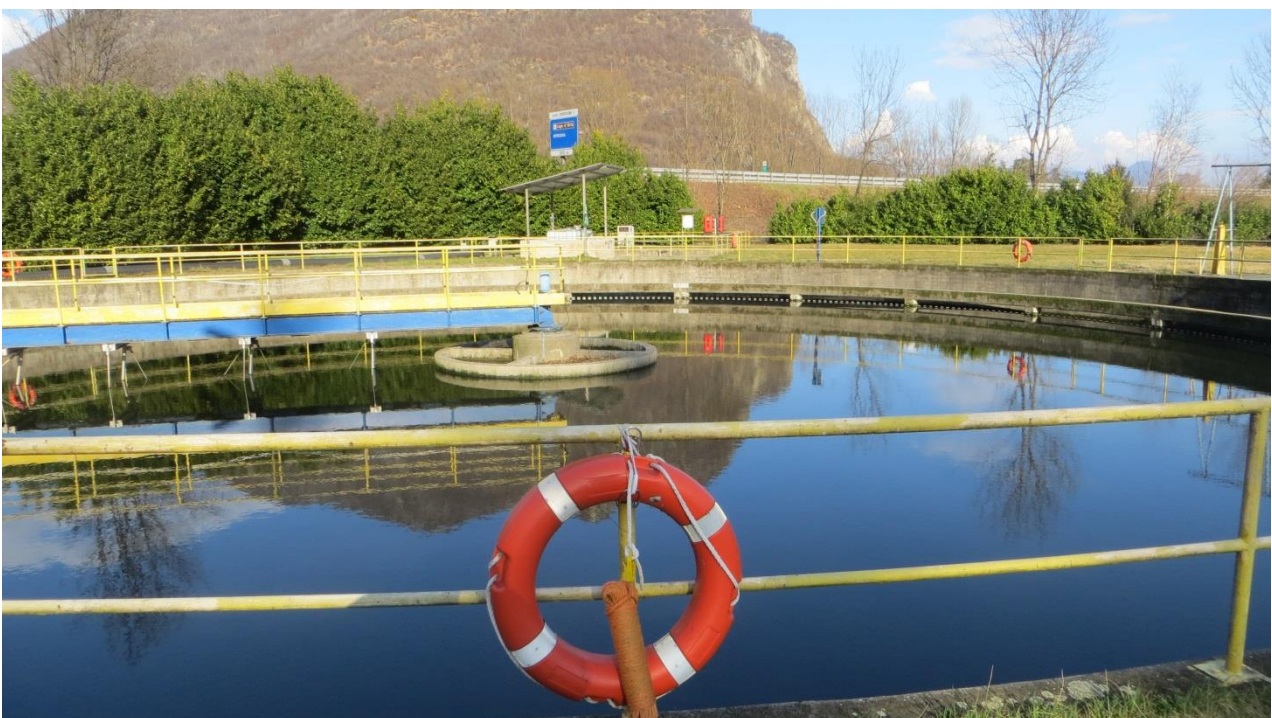
Impianto esistente: sedimentatore terziario esistente (da convertire in sed. Secondario).
