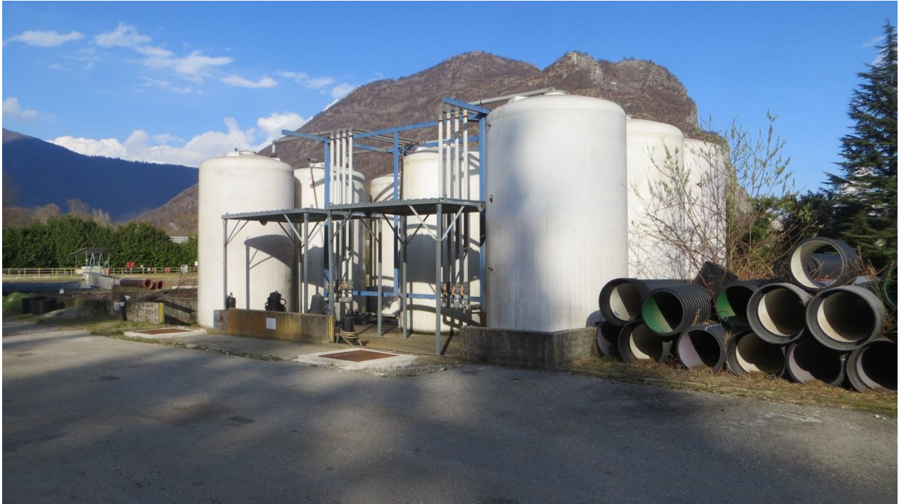
Impianto esistente: area silos da demolire
