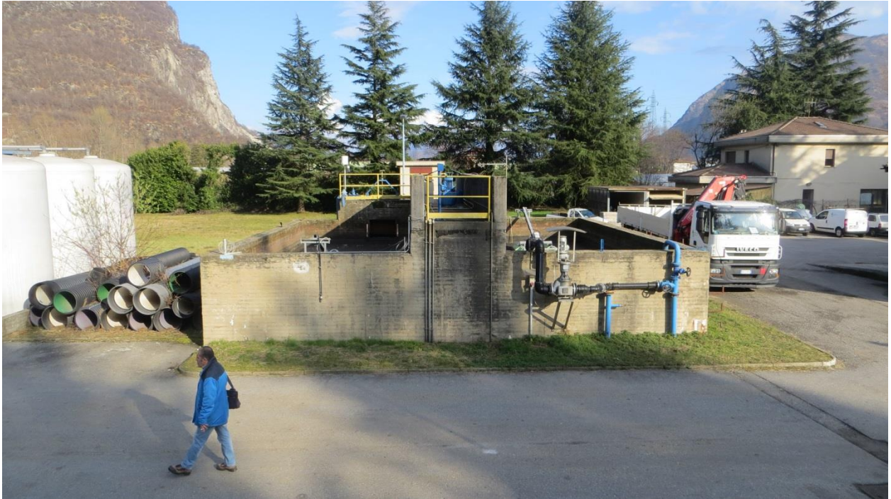
Impianto esistente: vasca di stabilizzazione fanghi esistente da mantenere).
