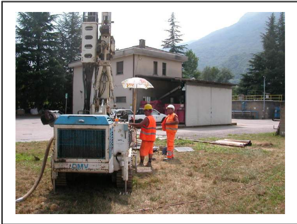
Foto 5: Postazione sondaggio S1.
